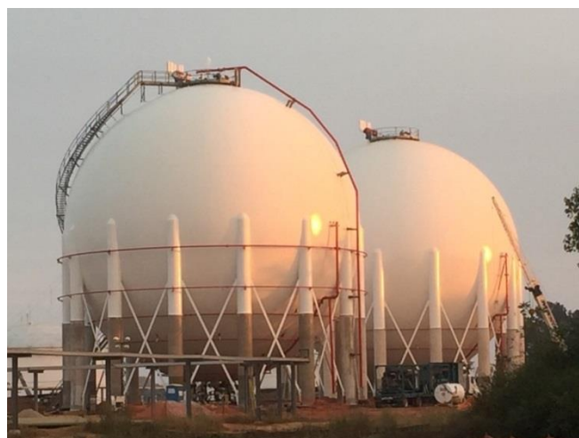
Figure 1.14: Sphères de stockage de Gaz.
