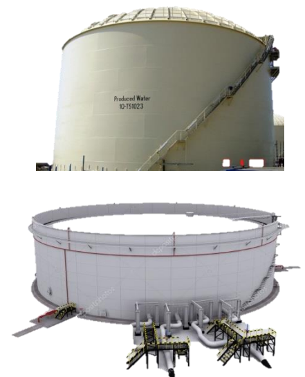
Figure 1.2: Bacs de stockage cylindriques verticaux.
